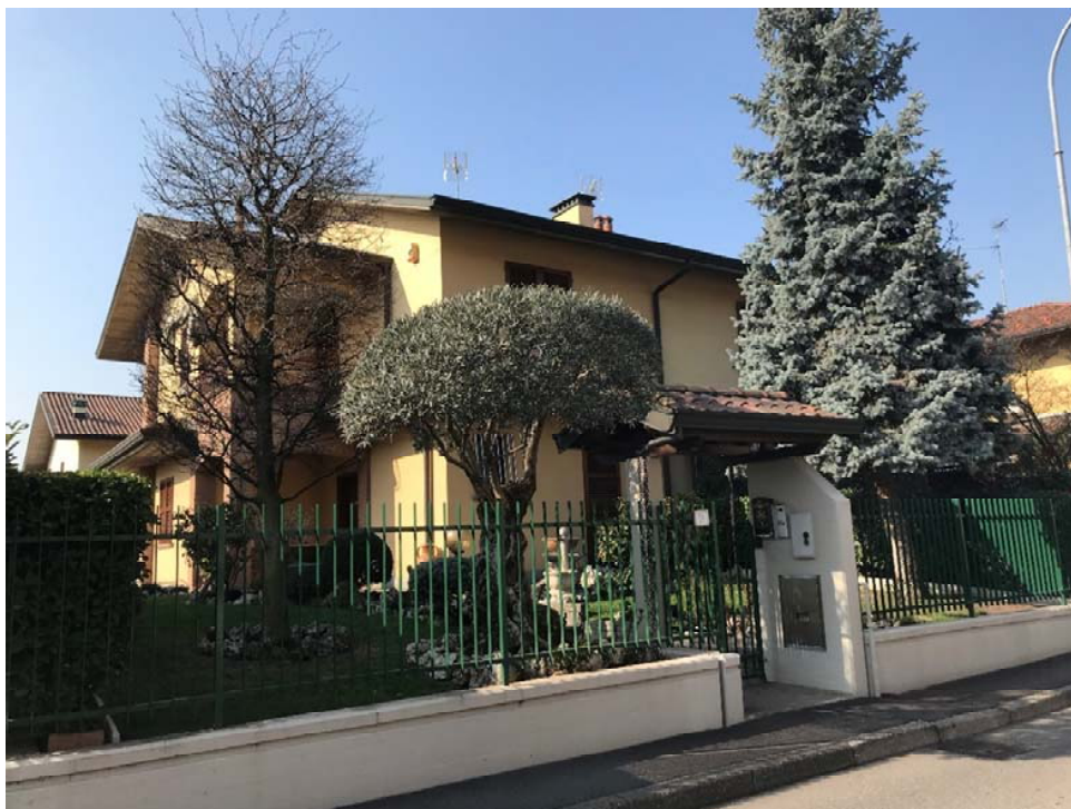
Foto n. 1: Prospetto principale sulla Via Villoresi.
